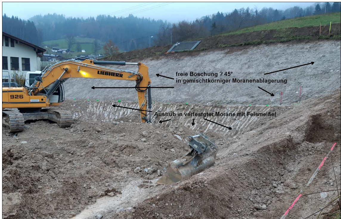
Abbildung 9: Böschung Feuerwehrhaus oben – freie Böschung ? 45°
