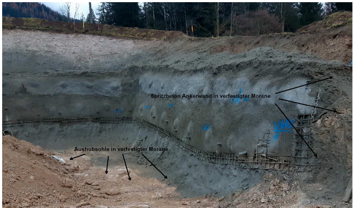
Abbildung 10: Böschung unten Feuerwehrhaus – Spritzbeton Nagelwand
