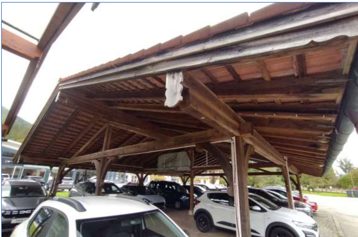
Abbildung 1: Windläden des Carports als potentielle Spaltenquartiere
