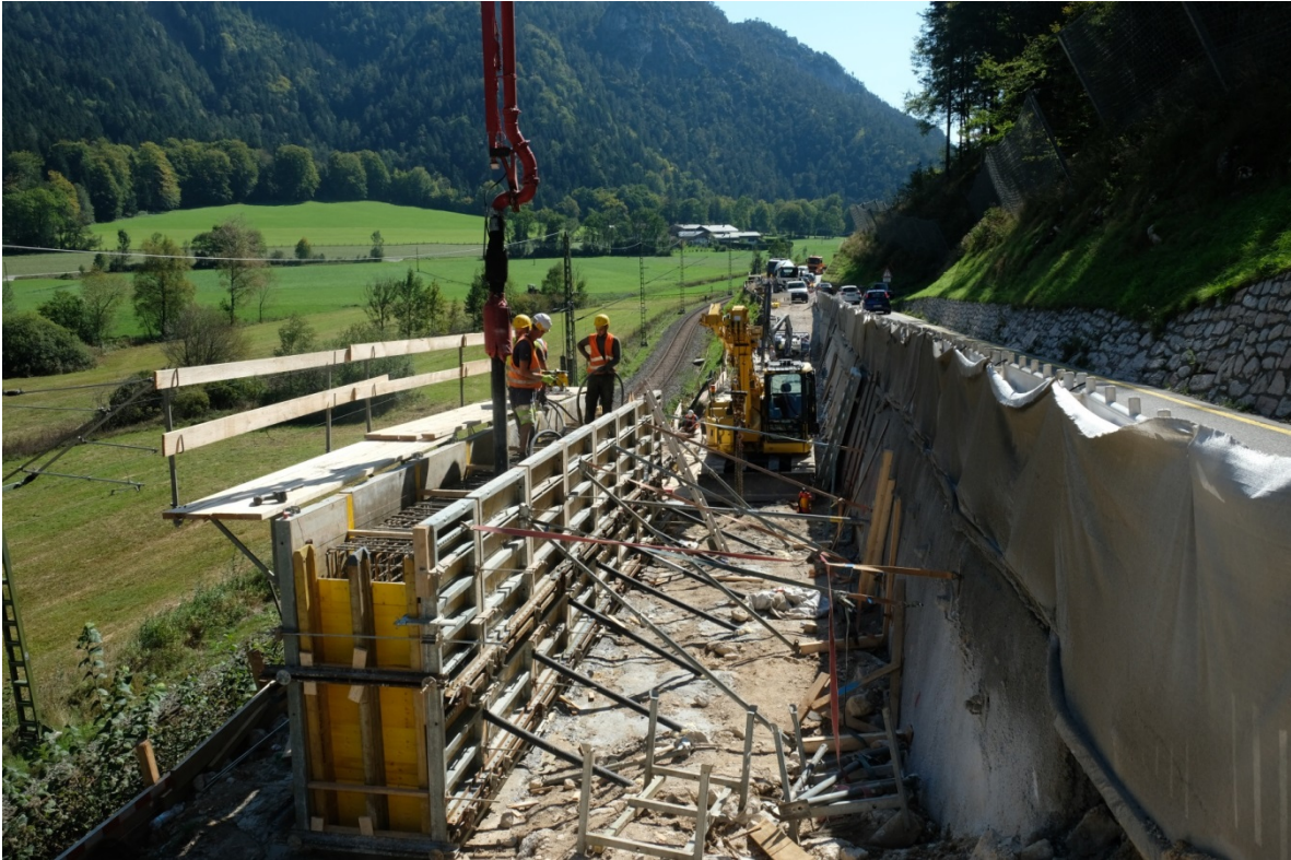
Baustellenfoto der Schadensbeseitigung im vergangenen Jahr
